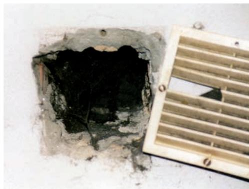
8.25 - Apertura di ventilazione in condizioni critiche sia per la realizzazione, sia per le condizioni di mantenimento
