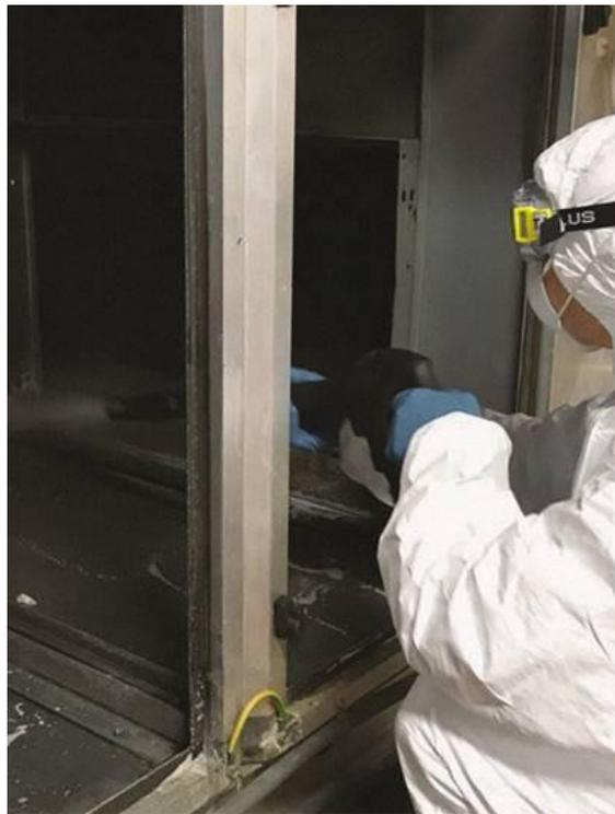
Foto 2. operazione di lavaggio con utilizzo di prodotto detergente sgrassante specifico
