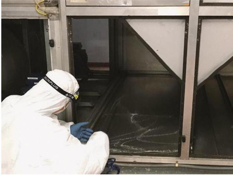
Foto 1. operazione di immissione sulle pareti interni di prodotto sanificante e sgrassante
