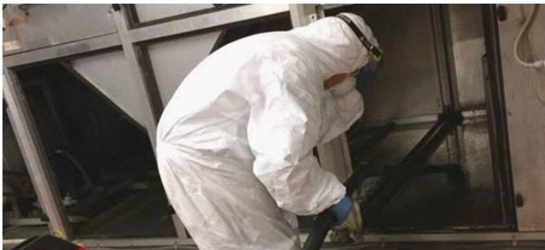
Foto 3. operazione di Asciugatura con specifico aspiratore liquidi e panni usa e getta
